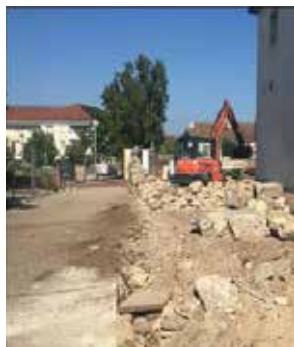
Destruction du mur en pierres, le 26/08
